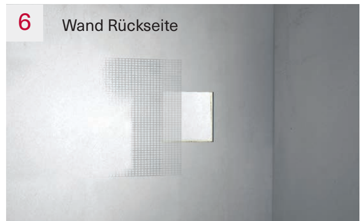
6 Wand Rückseite a. Zugiessen der Aussparung mit Mörtel (alternativ: Ausschäumen der Aussparung sofern die Aussparung nicht übermässig gross ist) Hohlraum zwischen IN-BOX und Mauerwerk: max. 3 cm b. Verputz der Rückwand durch den Gipser (Einbau Netz zur Rissüberbrückung)
