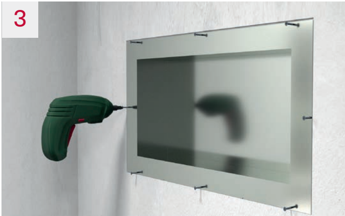
3 IN-BOX mittels beiliegender Befestigungsschrauben an der Wand befestigen (Bohrungen, Ø 6 mm)
